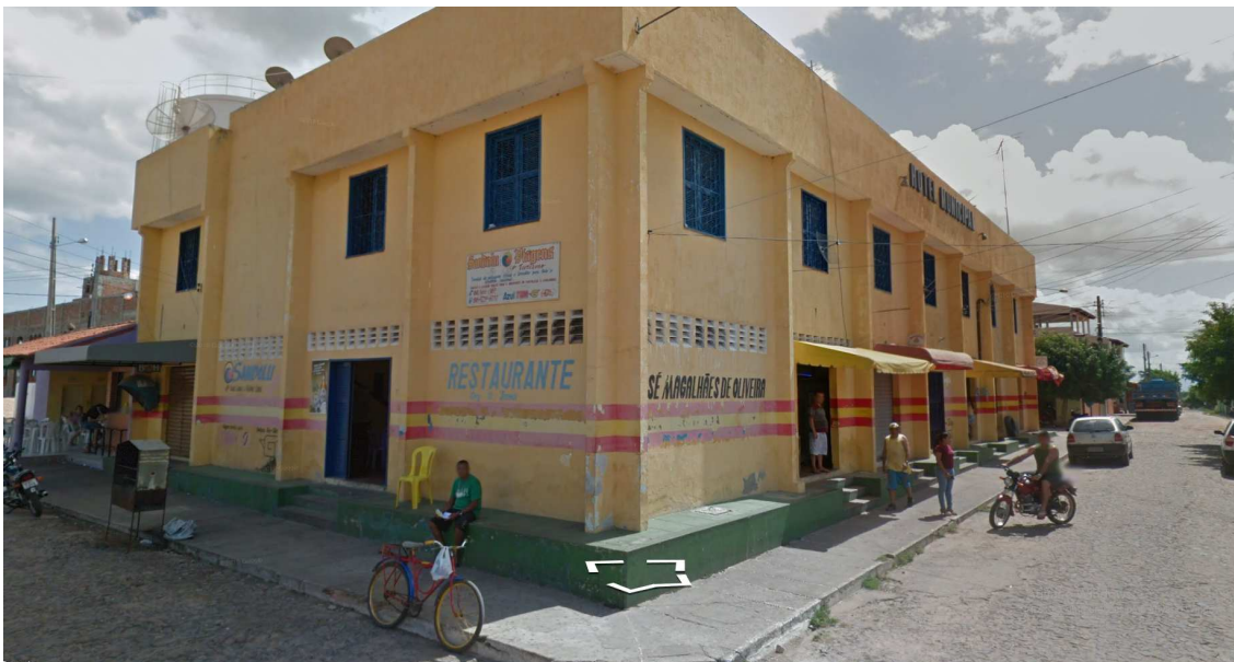
FOTO DO LOCAL DA OBRA
