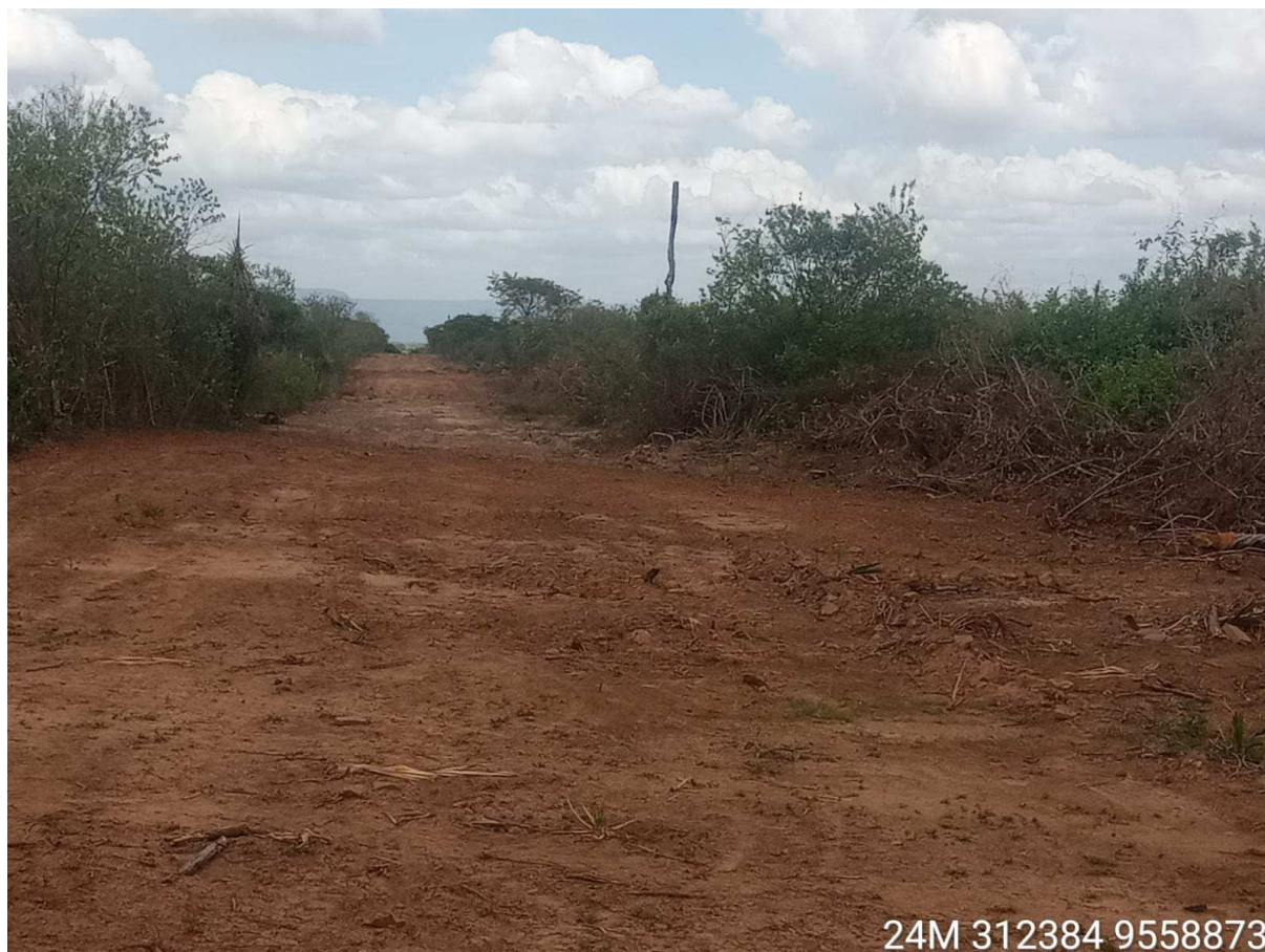
FOTO DO LOCAL DA OBRA
