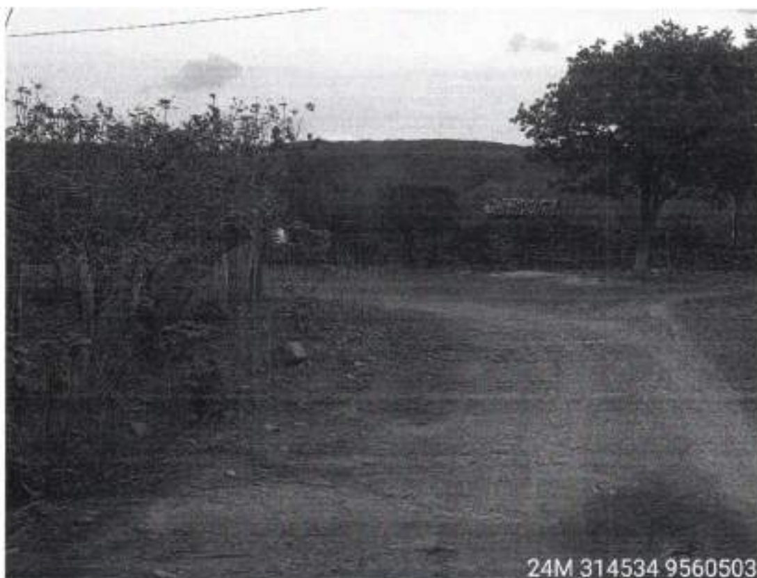
FOTO DO INICIO DO TRECHO 3 (SANHARÃO 1)
