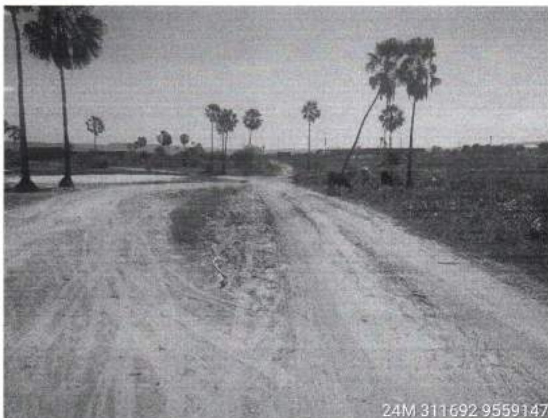
FOTO DO INICIO DO TRECHO 4 (SEDE)
