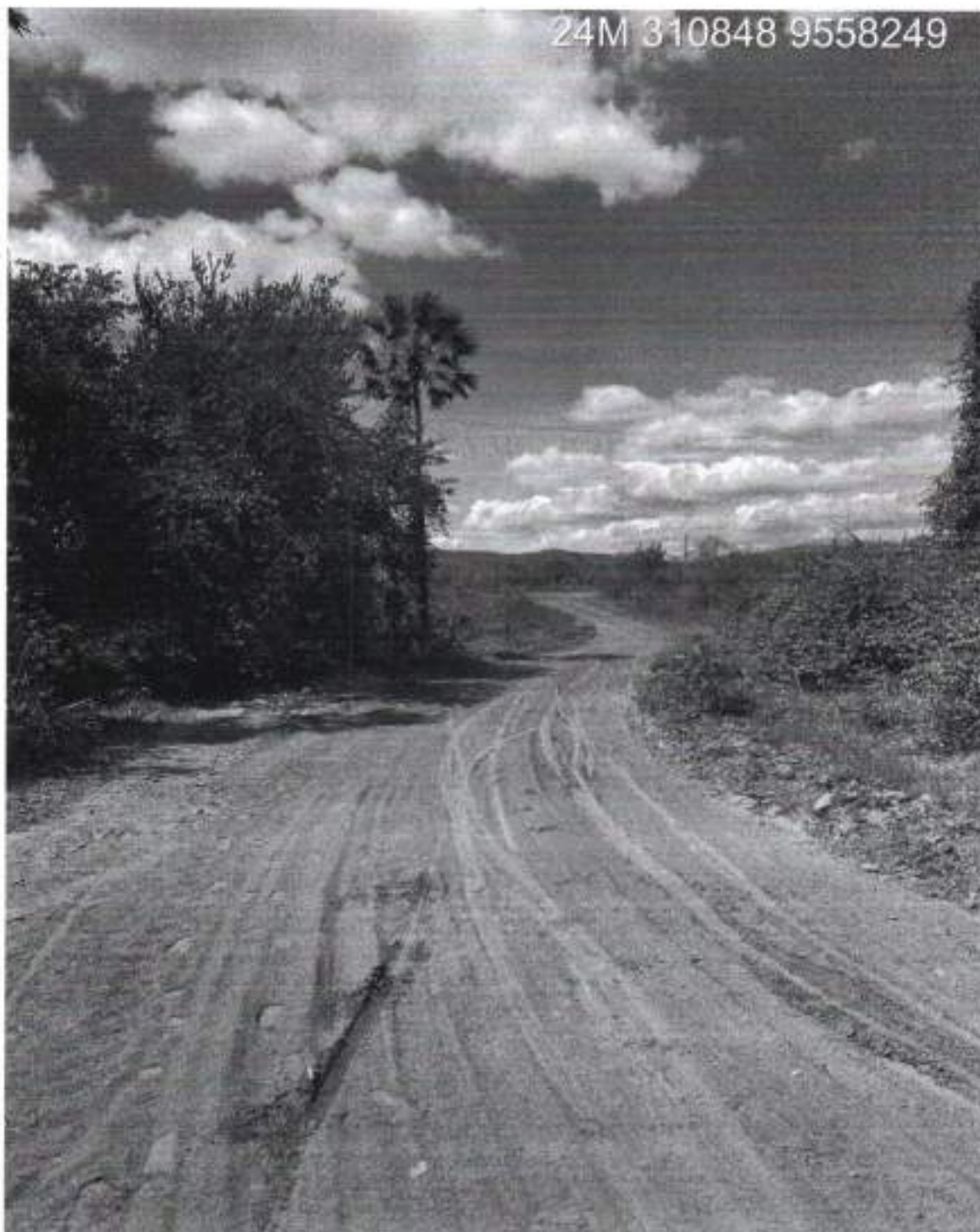
FOTO DO LOCAL DA OBRA
